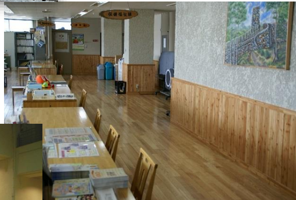
H21役場庁舎内装木質化
