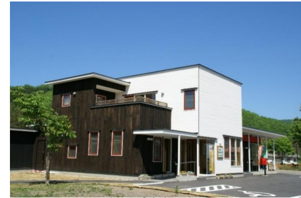
H24一の橋住民センター
