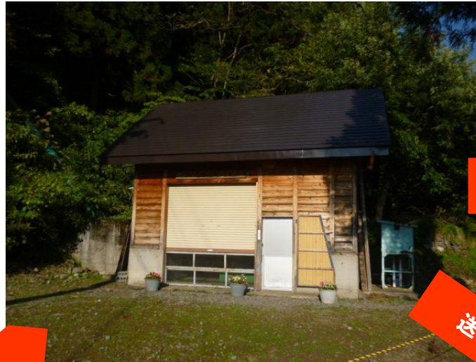
馬曲川水力発電所
