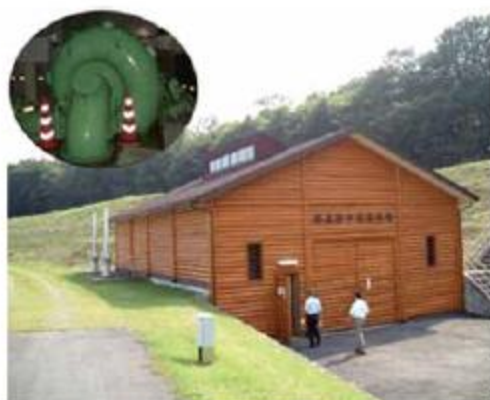
水力発電施設の外観と水車
