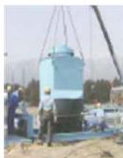
設置工事の様子
