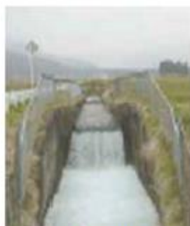
発電機設置前の水路
